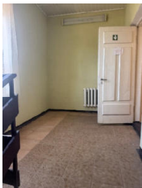
19.attēls. Kāpņu telpa (2.stāva telpa Nr.2 (telpu grupa 902))
