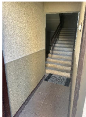
18.attēls. Kāpņu telpa (1.stāva telpa Nr.1 (telpu grupa 902))
